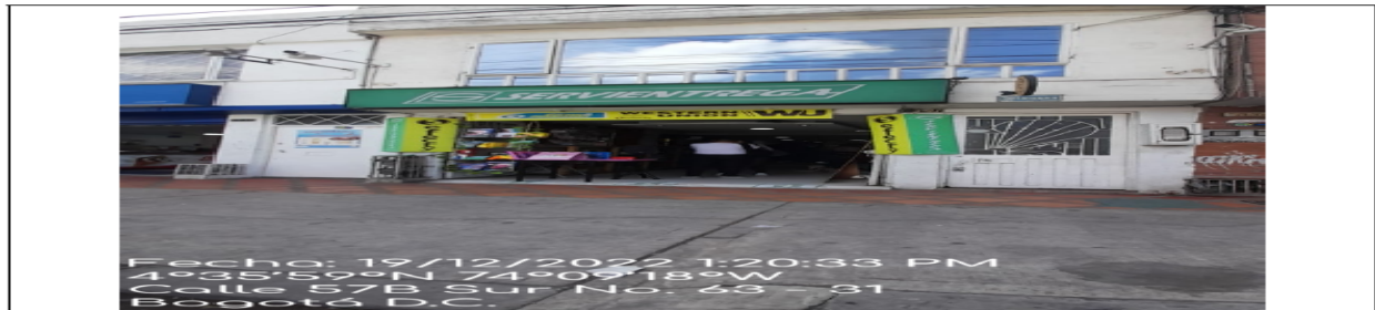
Fotografía panorámica en la cual se evidencia la fachada del predio ubicado en la CL 57 B Sur No. 63 – 31 de la localidad de Bosa, en donde se puede observar aviso en fachada y otros elementos, el aviso de fachada no cuenta con registro de Publicidad Exterior Visual otorgado por esta entidad, propiedad de la señora GINA LISETH ANGULO FAJARDO .
