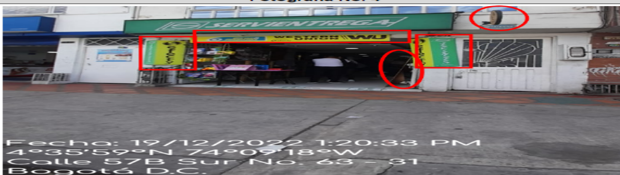
Fotografía donde se evidencia que el establecimiento cuenta con (4) elementos publicitarios visibles al espacio público y dos (2) ubicados en la puerta y ventana del establecimiento, adicional al único (1) permitido.
