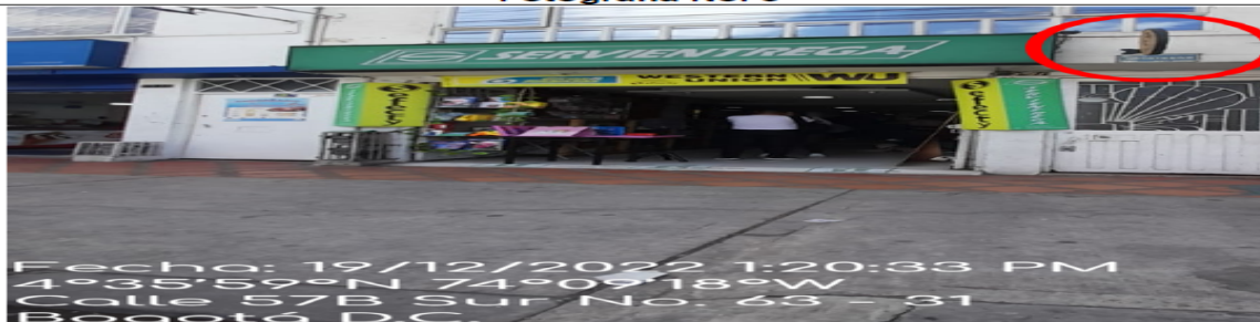
En la fotografía se evidencia un (1) elemento de Publicidad Exterior Visual saliente de la fachada ubicado en el antepecho del segundo piso.
